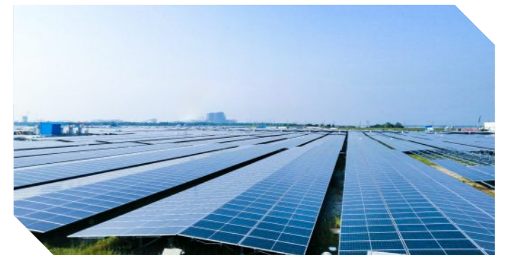
高耐食めっき鋼板 位置アイコン バングラデシュ 134 MW
