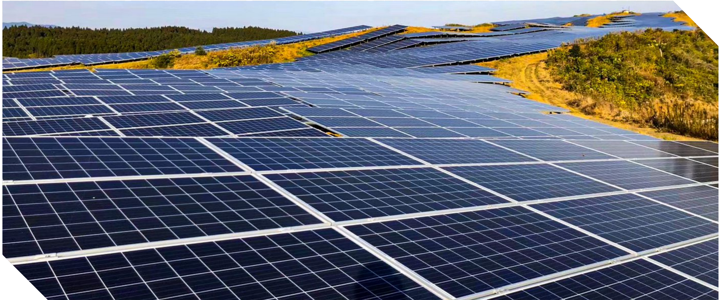
アルミ & スチール合金 日本・熊本 140 MW
