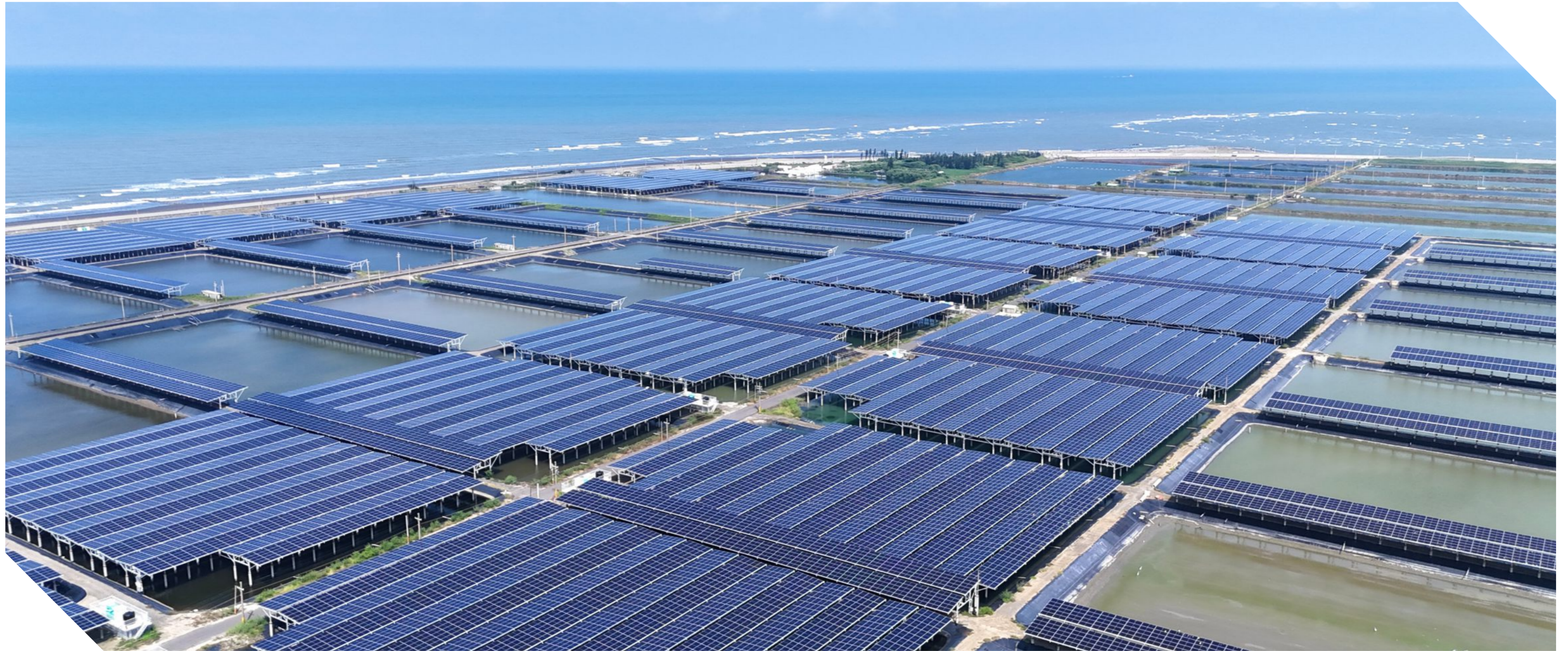
高耐食めっき鋼板 中国 128 MW
