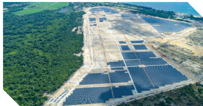
高耐食めっき鋼板 マレーシア 155 MW
