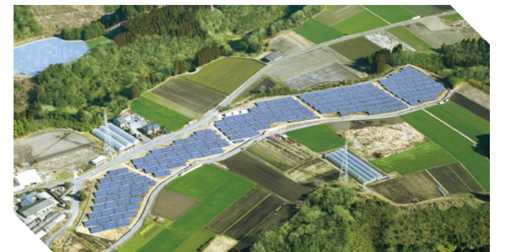
☎ スチール 📍 日本・宮崎 ⚡ 2.1 MW
